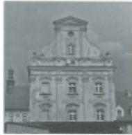
Po wyprowadzce Siostry Magdaleny z czepki budynku pozostał szpital dla dzieci. Po I Wojnie Światowej w budynku klasztoru powstała też schroniska młodzieżowe, sanatorium i dom starców. W roku 1953 kardynał Adolf Bertram odkupił budynek od państwa i założył tam placówkę „Caritas”. W klasztorze zamieszkały siostry Jachdanki i siostra sióstr. Siostry prowadziły też szkoły dla dziewcząt w zakresie prowadzenia domu, ogrodu i uprawy psów. Klasztor przetrwał nawałnicą II Wojny Światowej i pełni swoją funkcję do dziś.
