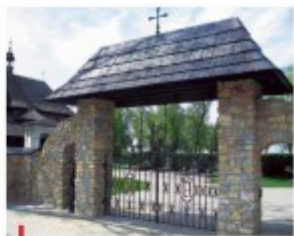
Odbudowa nowego ogrodzenia.
