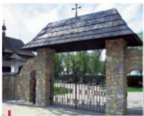
Główna brama nowego ogrodzenia.
